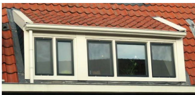
Dakkapel met schuin pannendak
