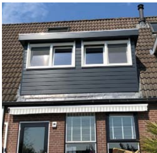
Dakkapel montage op de dakgoot
