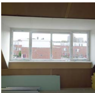
Aftimmering met vensterbank
